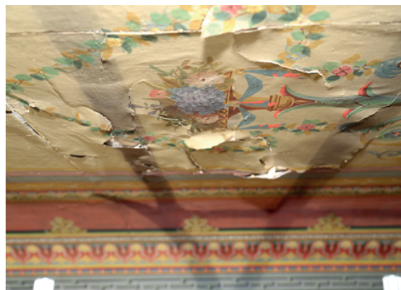
Ausschnitt einer mit Papierkaschierungen gesicherten Wandmalerei im Vaterländersaal
