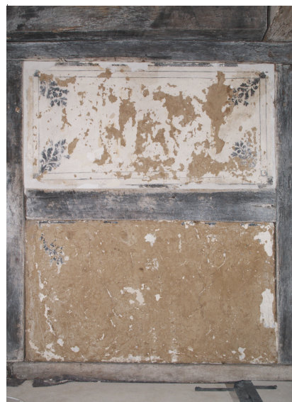
Zwischenzustand der Westwand nach der Freilegung
