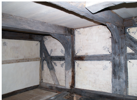
Blick in die Nord-Ostecke nach der Fertigstellung
